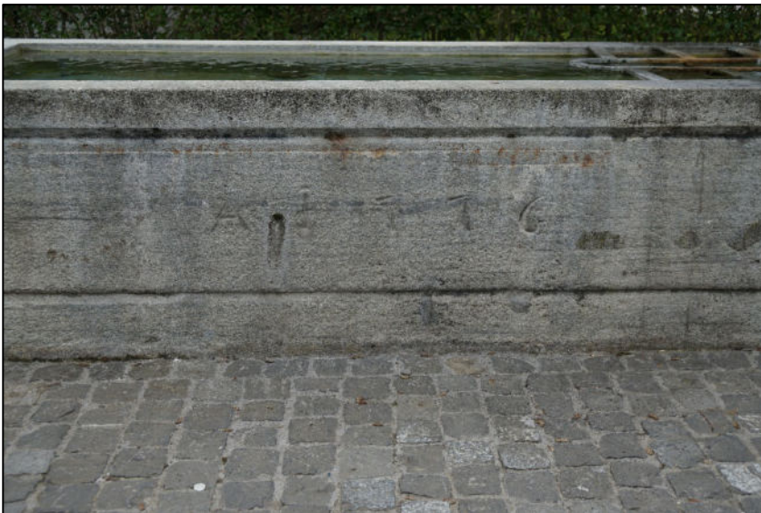
Detail der nördlichen Trogwand
