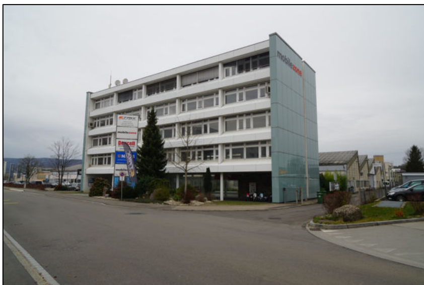
Verwaltungsgebäude, Ansicht von Süden
