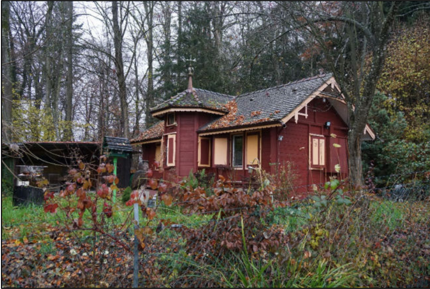
Ansicht von Südosten
