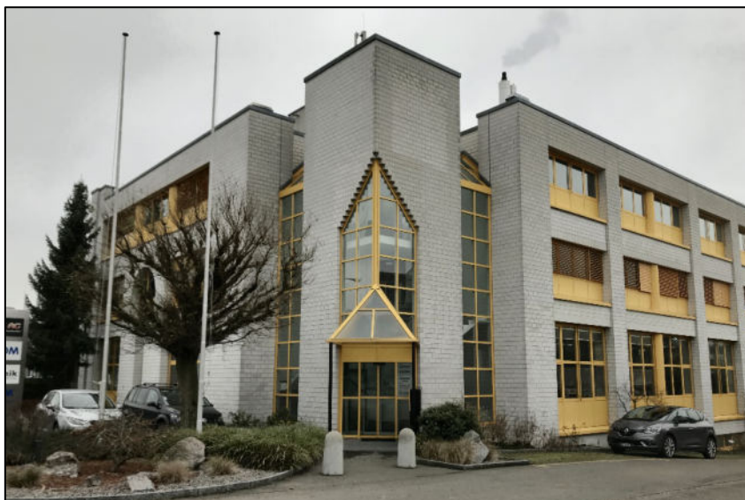
Ansicht von Norden mit aufgelöster Gebäudeecke
