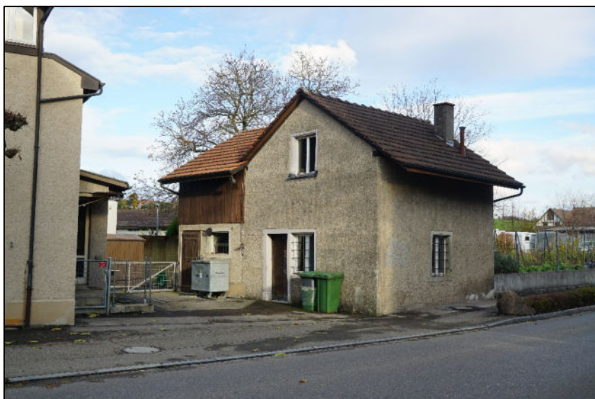
Nebengebäude, Ansicht von Südwesten
