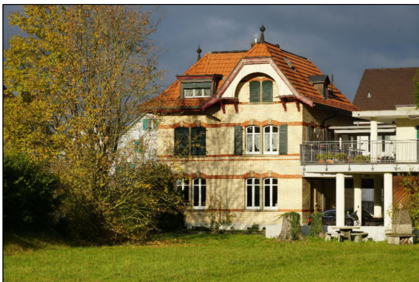
Ansicht von Südosten
