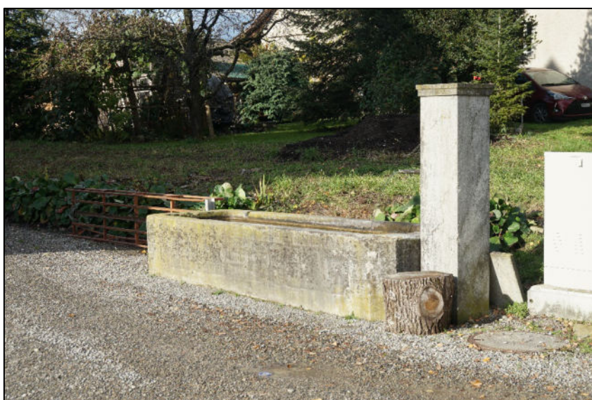
Brunnen, Ansicht von Südosten
