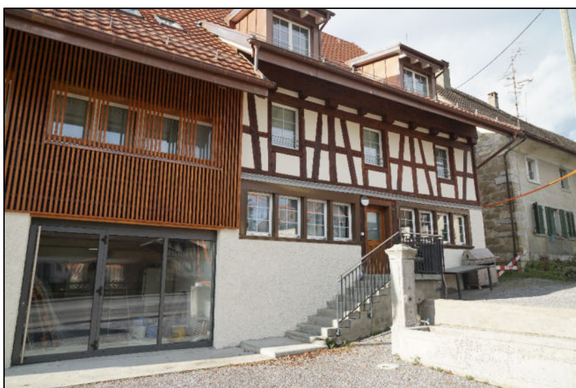
Teilansicht von Südosten
