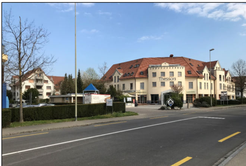
Ansicht von Süden (Hoteltrakt)
