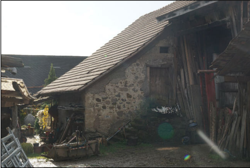
Ansicht von Norden
