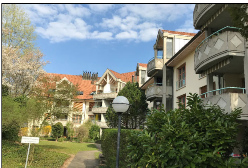
Ansicht der Innenhof-Fassade
