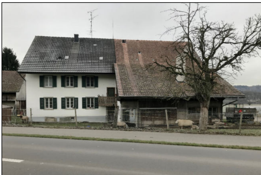
Ansicht von Norden
