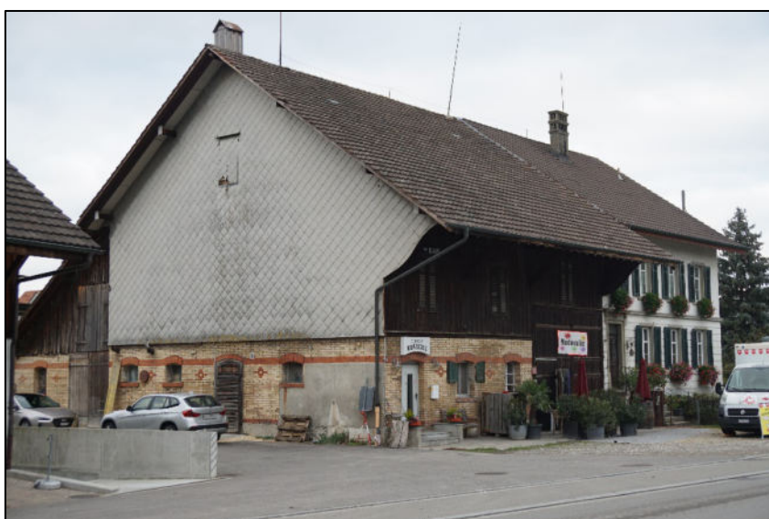
Ansicht von Südosten
