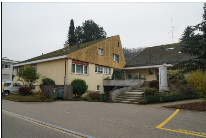
Strassenansicht von Norden
