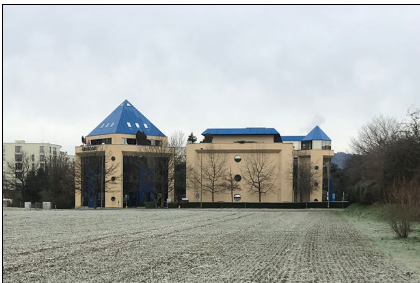
Ansicht von Südosten: Büroturm, Schmalseite Gewerbebau, Treppen-turm
