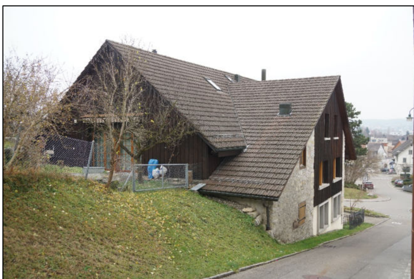
Ansicht von Südosten
