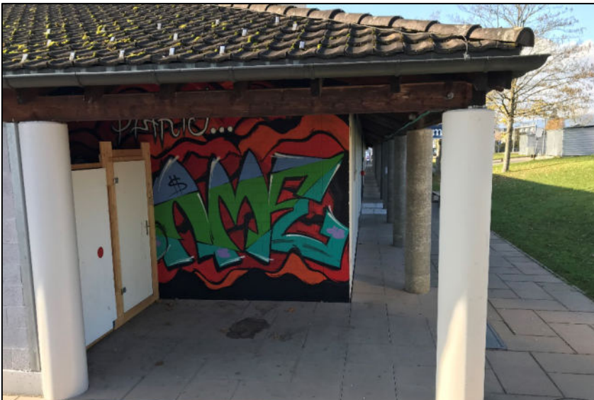
Säulengang an der Nordfassade
