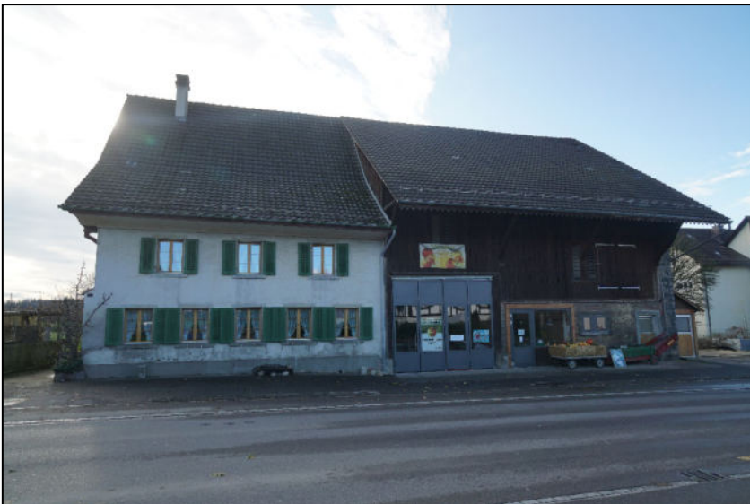
Ansicht von Norden
