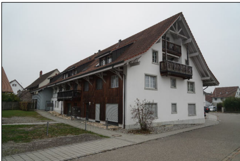
Ansicht von Norden
