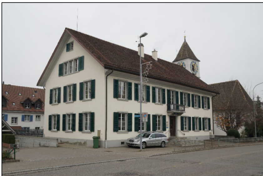
Ansicht von Südosten
