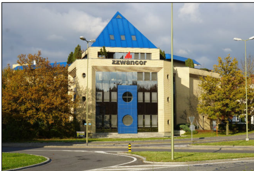
Ansicht Büroturm von Süden, in der Mitte des Fassadenfeldes ein über-grosses, blindes Türelement
