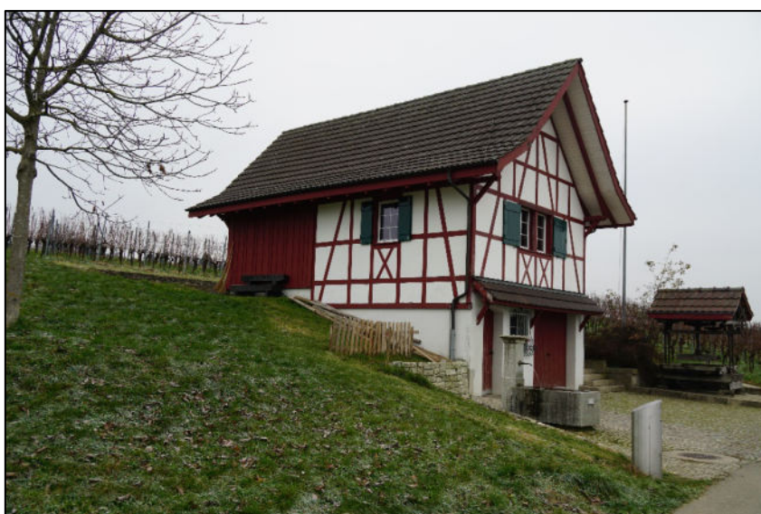
Ansicht von Osten. An der Gebäude- ecke lässt sich das Fachwerk leicht als vorgeblendet erkennen.
