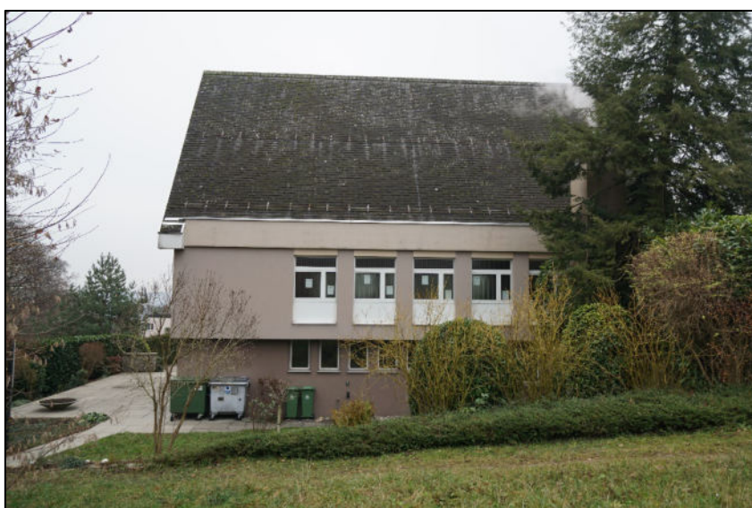
Hauptfassade von Westen
