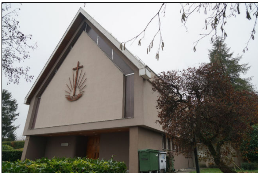
Ansicht von Norden
