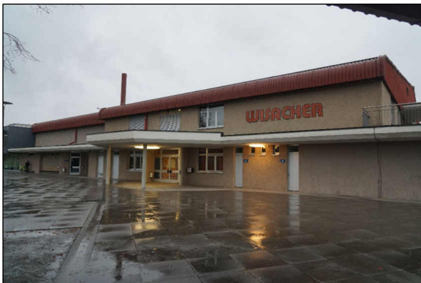
Ansicht Eingangsfassade von Süd- osten
