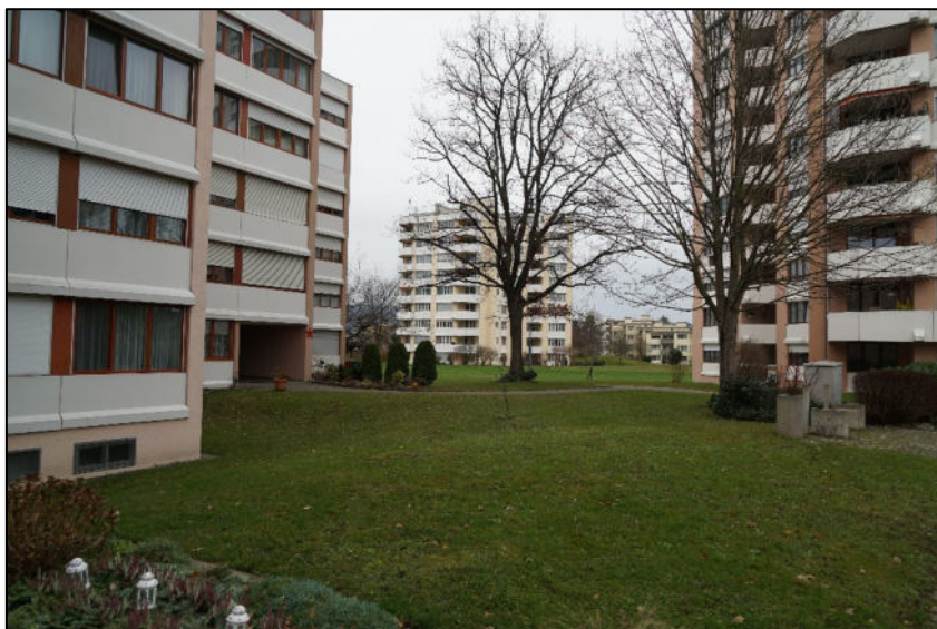
Ansicht MFH und zwei Hochhäuser von Südosten
