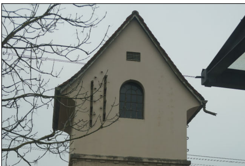
Detailansicht der nordöstlichen Giebelfassade oberhalb des Gurtbandes
