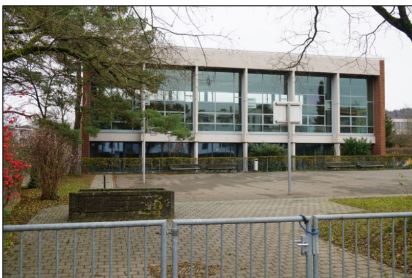
Ansicht Turnhalle von Nordwesten
