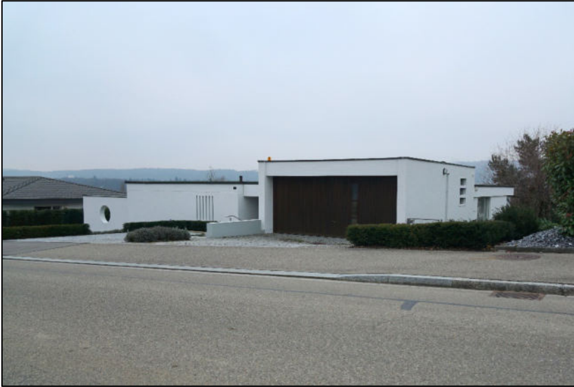
Ansicht Strassenfassade von Norden (Wandflügel links im Bild wurde später ergänzt.)
