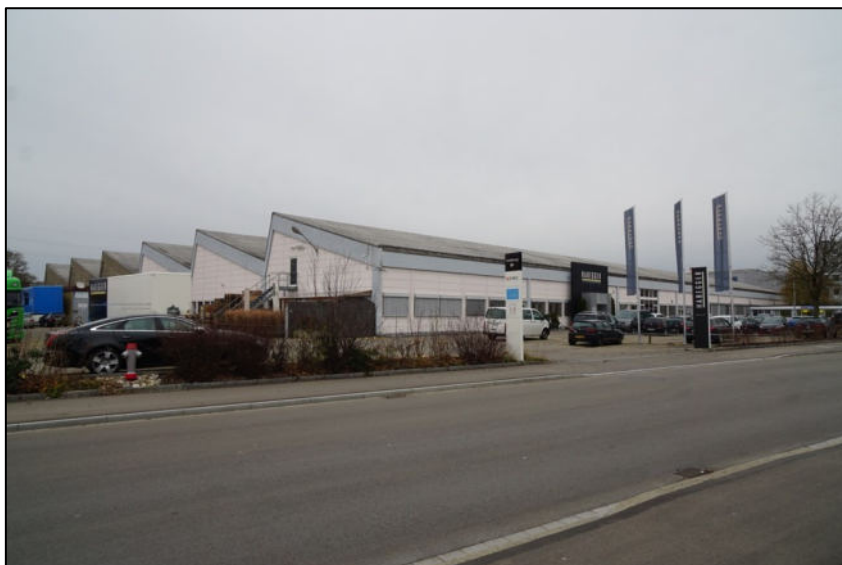
Shedhalle, Ansicht von Südwesten
