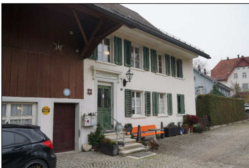
Teilansicht von Südwesten
