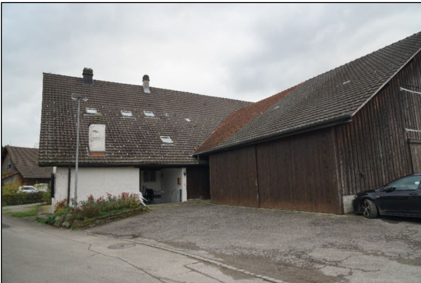
Ansicht von Westen
