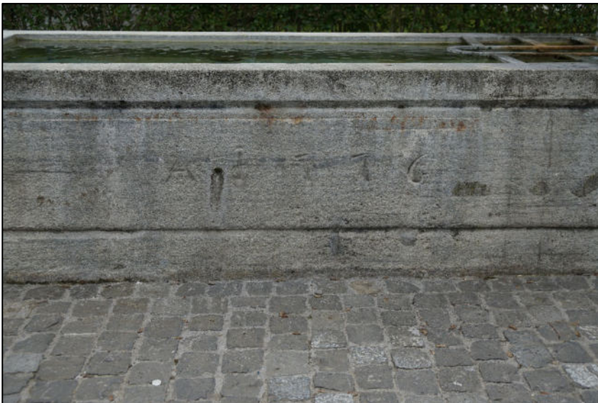
Detail der nördlichen Trogwand
