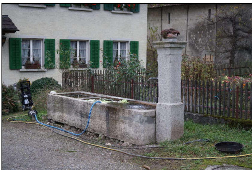
Brunnen im Vorgarten. Ansicht von Südwesten
