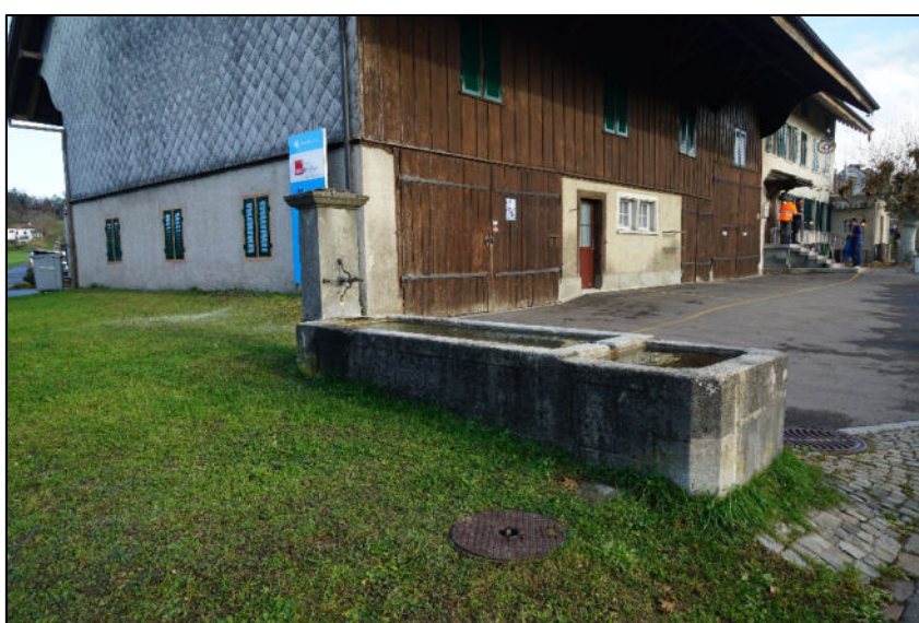
Teilansicht mit Brunnen von Südwesten
