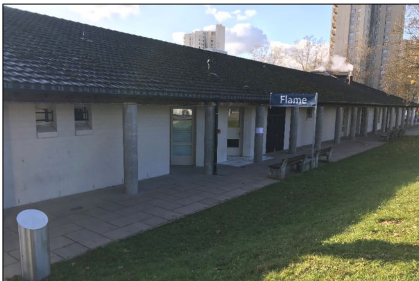
Nordfassade von Osten
