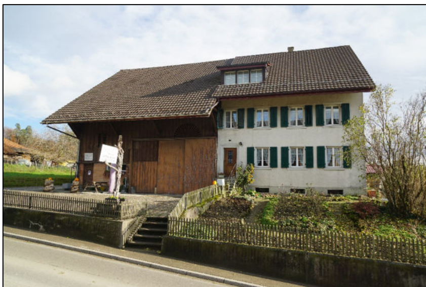
Ansicht von Westen
