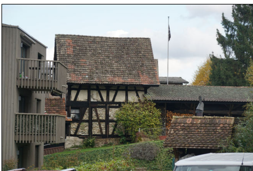
Ansicht von Westen
