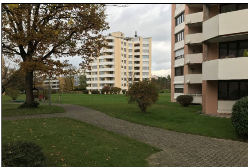
Plastisch gegliederte vorfabrizierte Fassadenelemente
