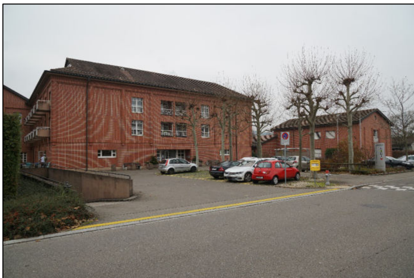
Die Fassade des Alters- und Pflegeheims ist zur Feldblumenstrasse einfach gestaltet; davor die Allee.
