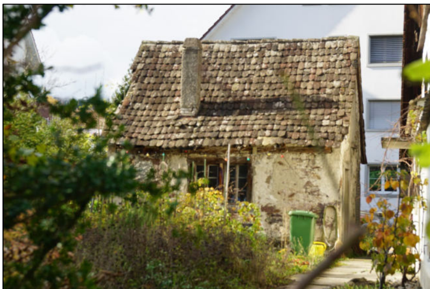
Ansicht von Osten
