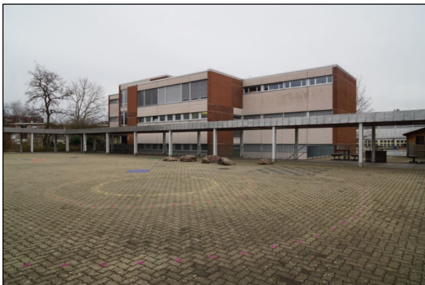
Ansicht Klassentrakt mit Umgang von Südwesten
