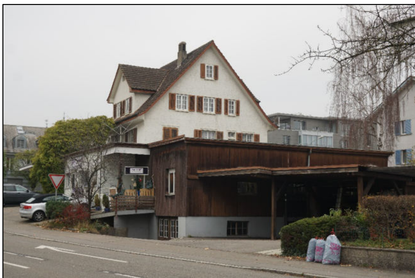
Ansicht von Osten
