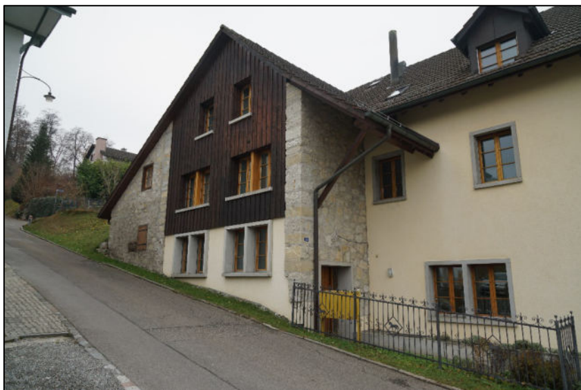
Teilansicht von Nordosten
