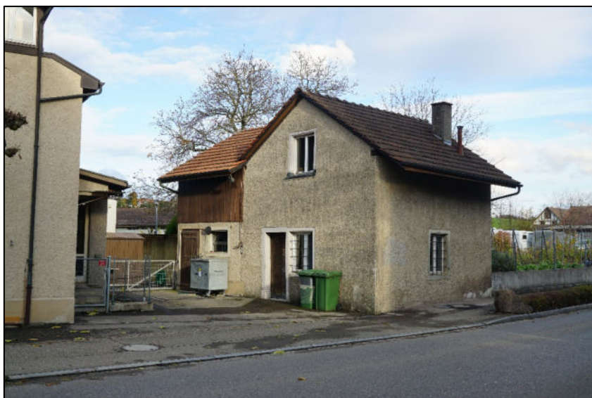
Nebengebäude, Ansicht von Südwesten
