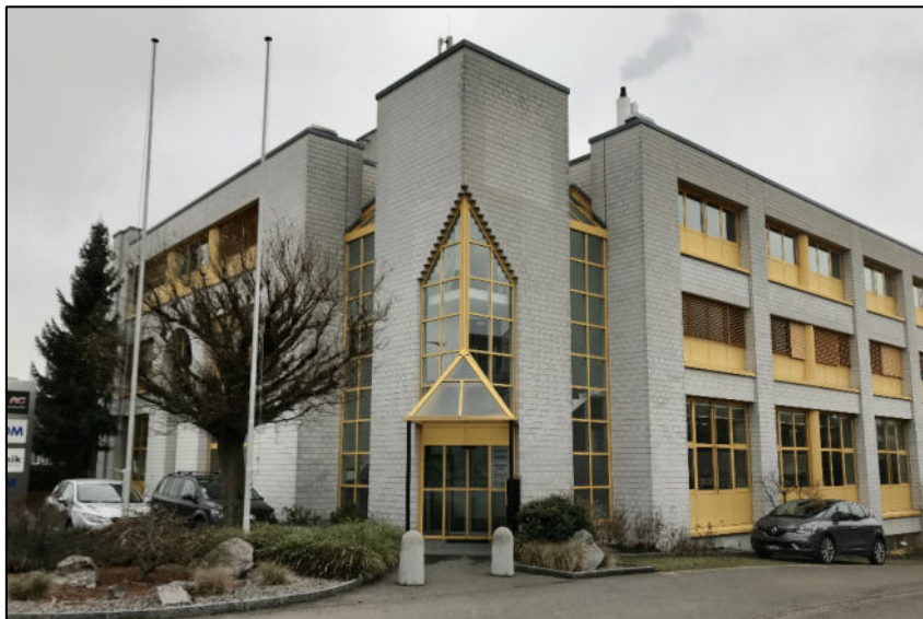
Ansicht von Norden mit aufgelöster Gebäudeecke
