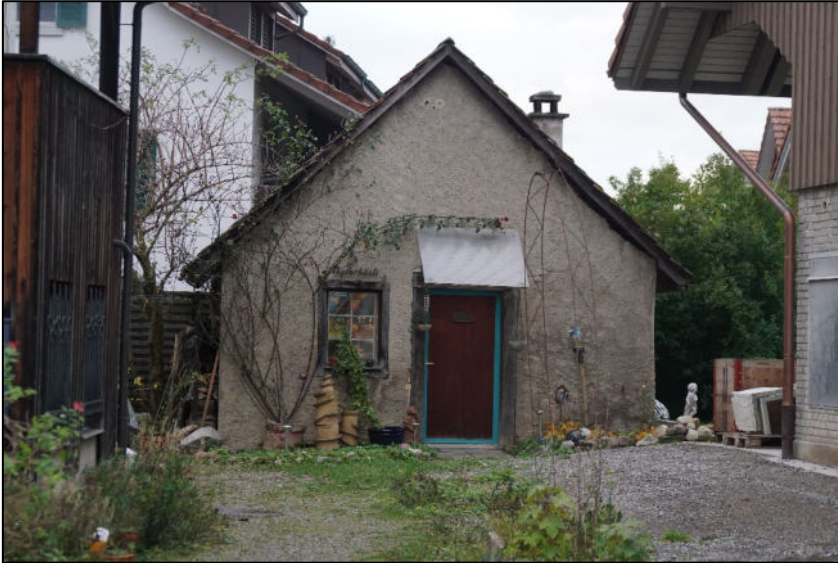
Ansicht von Osten
