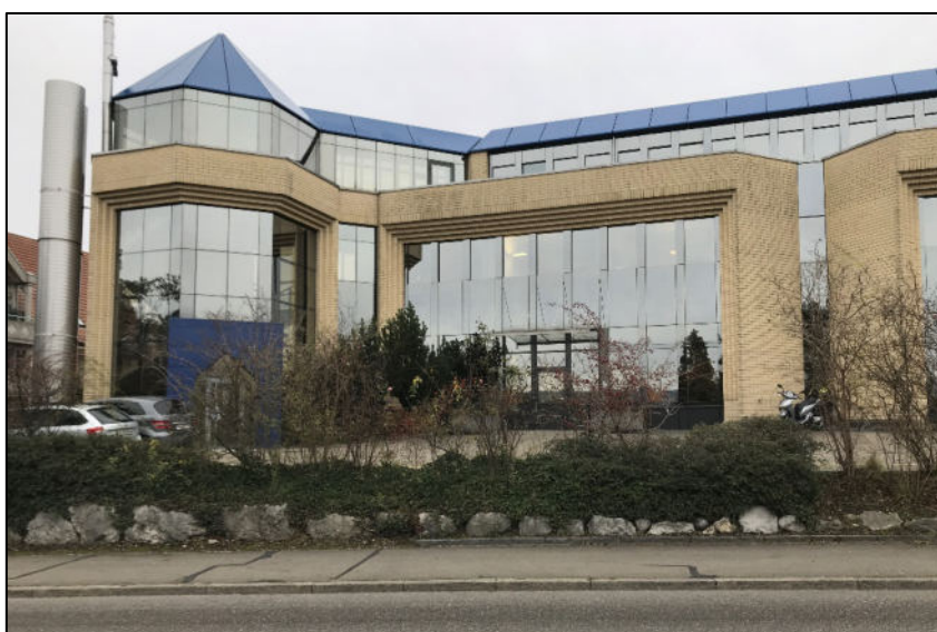
Ansicht von Osten: Nordseitiger Treppenhausturm
