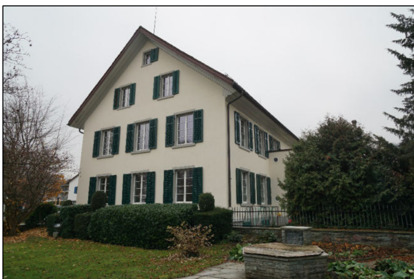
Giebelfassade von Norden
