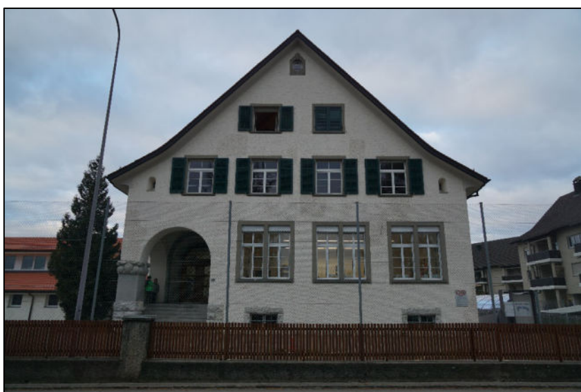
Hauptfassade von Süden
