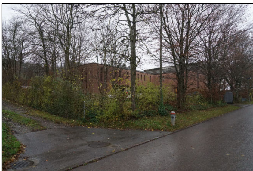
Ansicht von Osten
