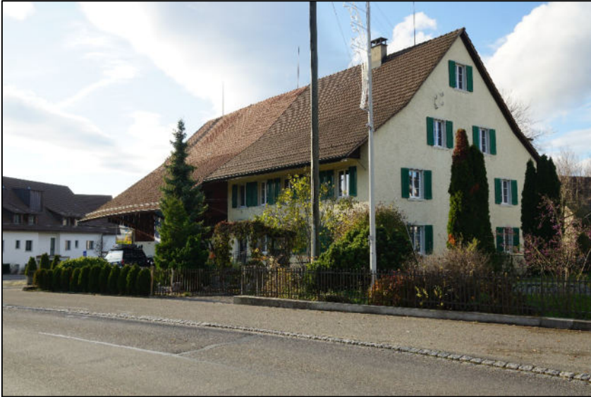
Ansicht von Osten
