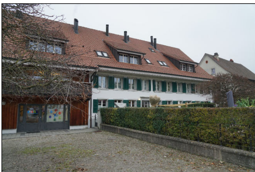
Teilansicht von Südwesten
