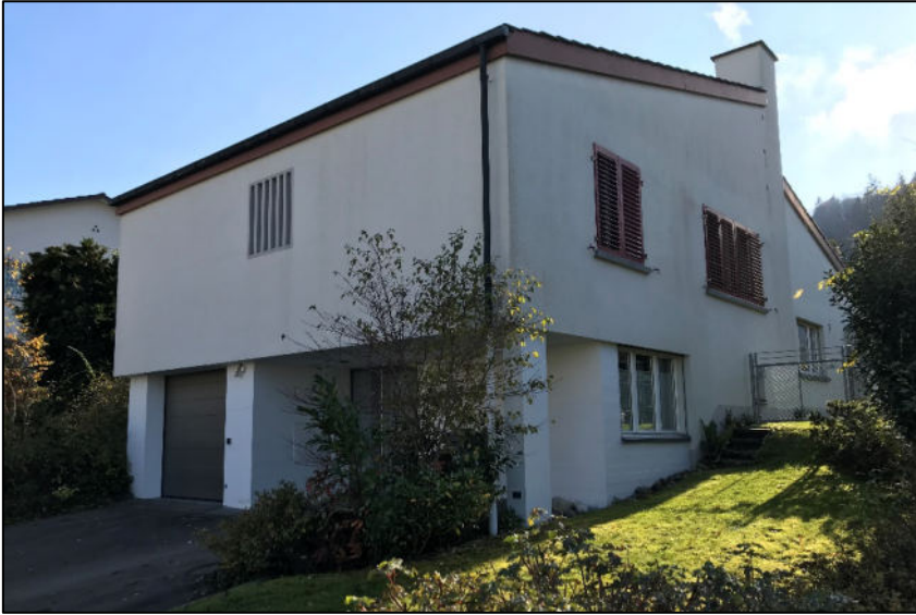
Ansicht Strassenfassade von Südosten
