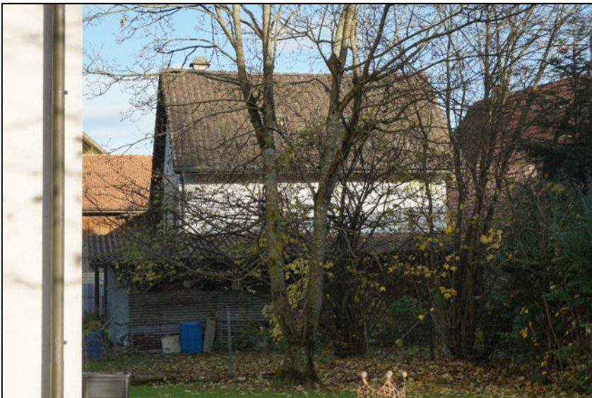
Ansicht von Osten
