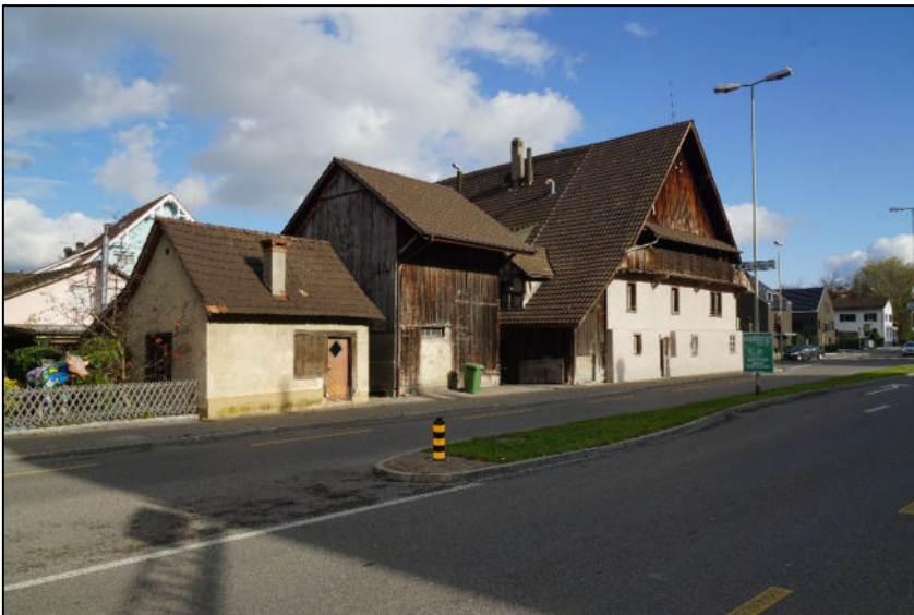
Übersicht von Südwesten
