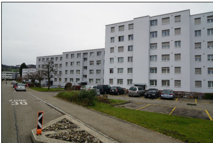
Rückfassade, Ansicht von Osten
