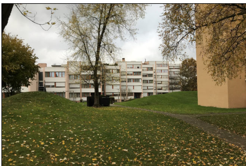
Ansicht MFH von Nordosten
