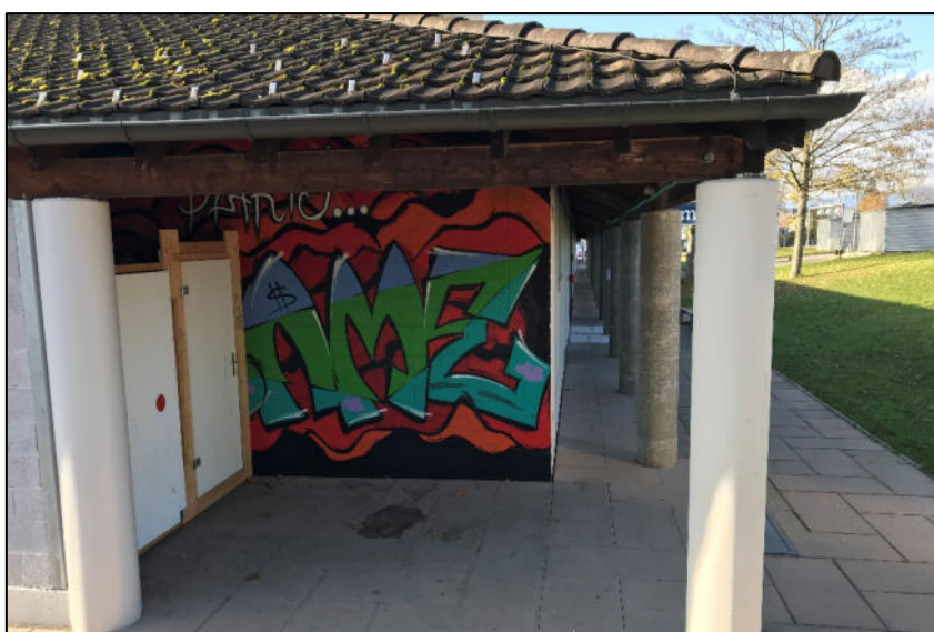
Säulengang an der Nordfassade
