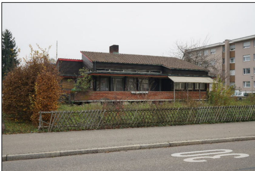
Ansicht Südfassade mit über das Gebäude hinausragender Terrasse
