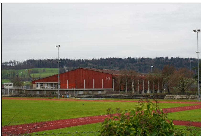
Ansicht Halle von Norden
