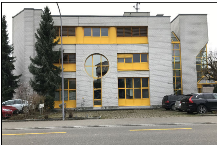
Stirnfassade von Nordosten
